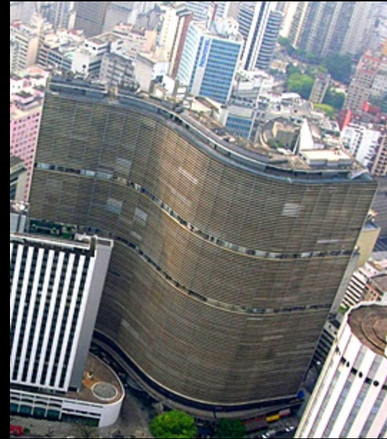
Oscar Niemeyer. Edifício Copan. Década de 50. São Paulo.
